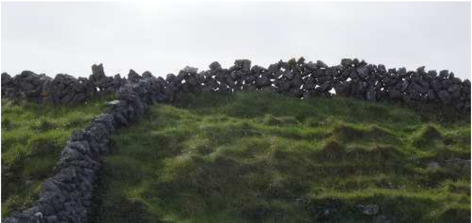
Les murets en pierre sèches "en dentelle"
